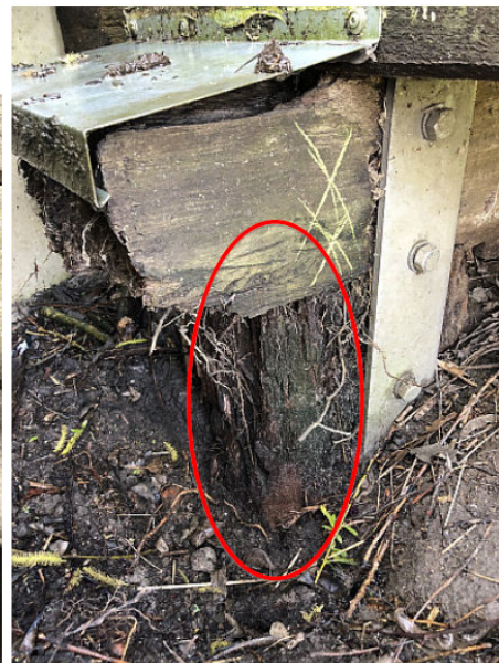
Abbildung 19: links: Hauptträger unter Blechabdeckung teils komplett aufgelöst; rechts: Auflager im bindigen Boden
