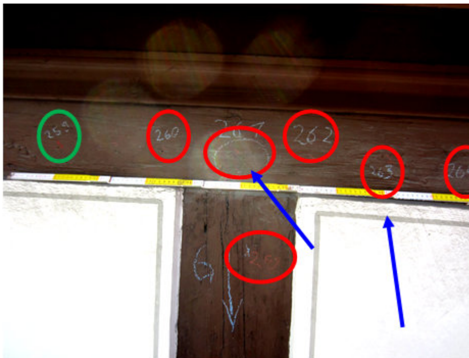
Abbildung 5: Lage der Bohrwiderstandsmessungen
