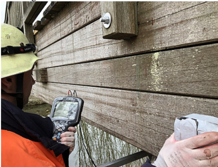
Abbildung 11: Ultraschallechomessung am Bauwerk am Bongossiträger
