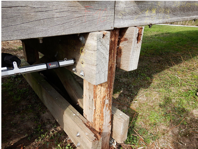
Abbildung 12: Bohrwiderstandsmessung an Trägern an Stützen
