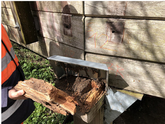
Abbildung 19: links: Hauptträger unter Blechabdeckung teils komplett aufgelöst; rechts: Auflager im bindigen Boden
