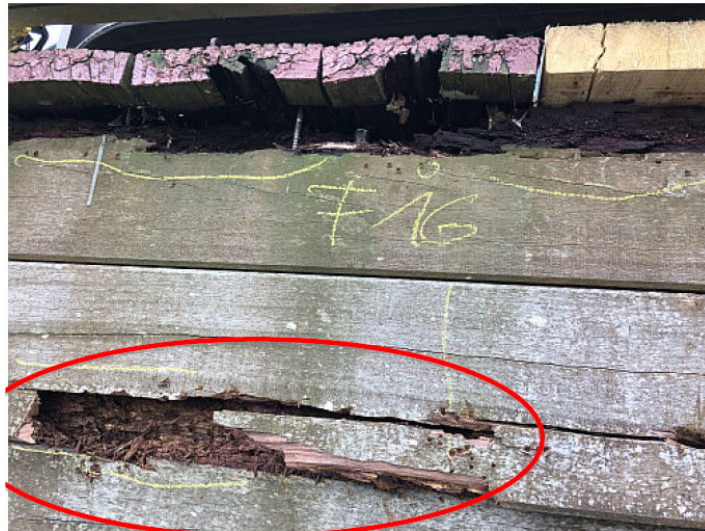
Abbildung 15: Problem bei Bongossi: selbst mit Abklopfen ist eine ausgeprägte innere Schädigung in der Tiefe von mehreren Zentimetern oft nicht möglich – nur mit Ultraschallechomessung und Bohrwiderstand können tiefliegende innere Schäden gefunden werden
