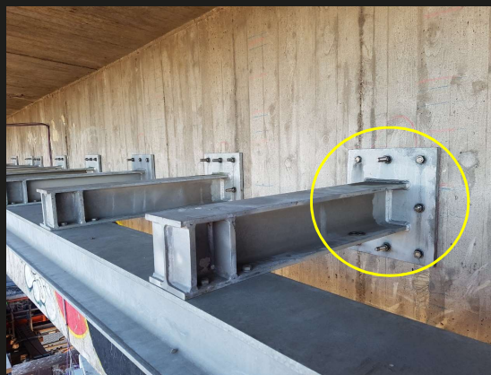
Befestigte Schiene am Überbau
