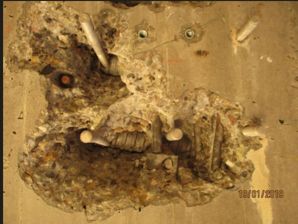
Geöffnete Stelle am Überbau nach Abnahme der Fußplatten der Schiene
