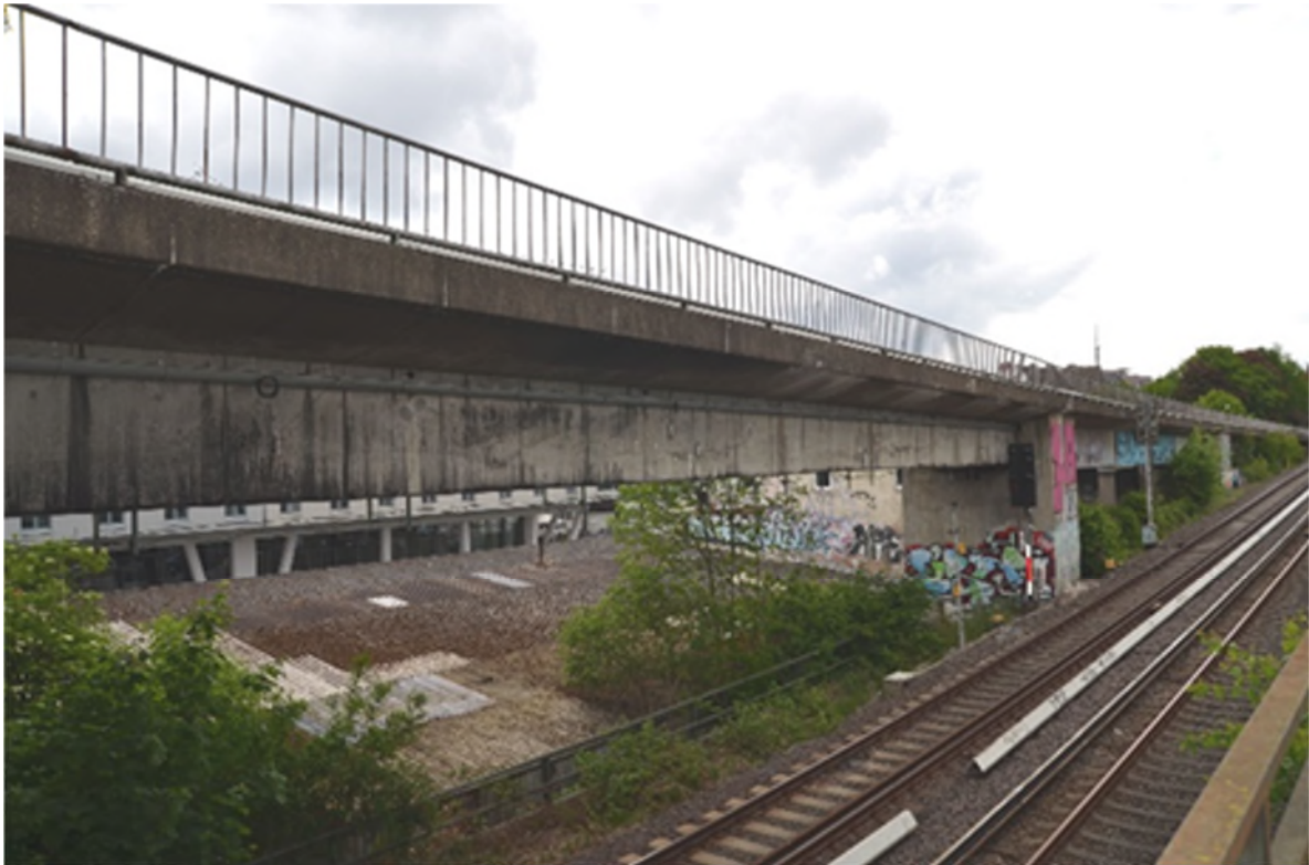
Abb. 1 Ansicht der Überbauten des untersuchten Bauwerkes. Quelle: MKP GmbH
