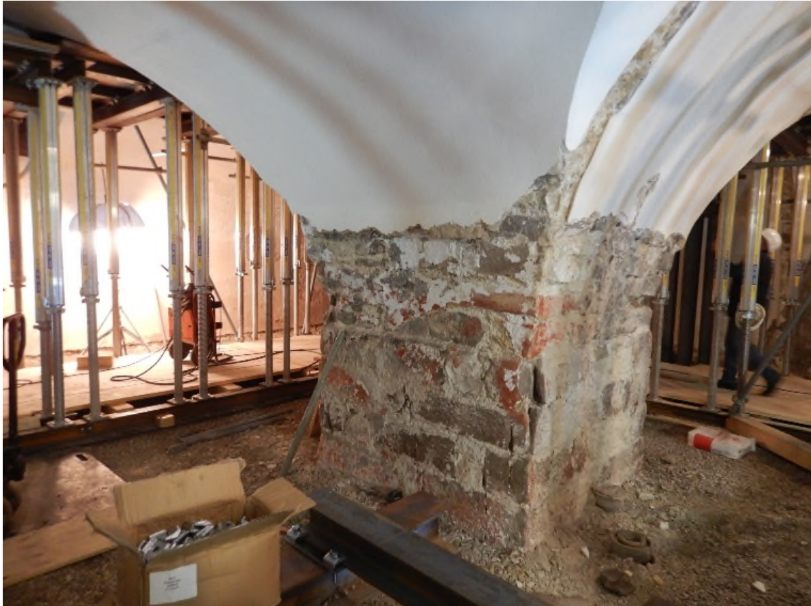
Abb. 5 Ansicht eines untersuchten Mauerwerkspfeilers aus Sandstein. Quelle: MKP GmbH
