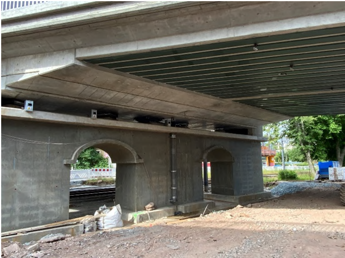
Abb. 7 Ansicht Untersuchungsbereich der WiB -Brücke. Quelle: MKP GmbH
