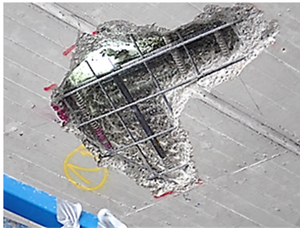
Abb.5: Freilegung von Spanngliedern zur Untersuchung des Spannstahls und Versuchsdurchführung zur Spannstahlbruchdetektion.
