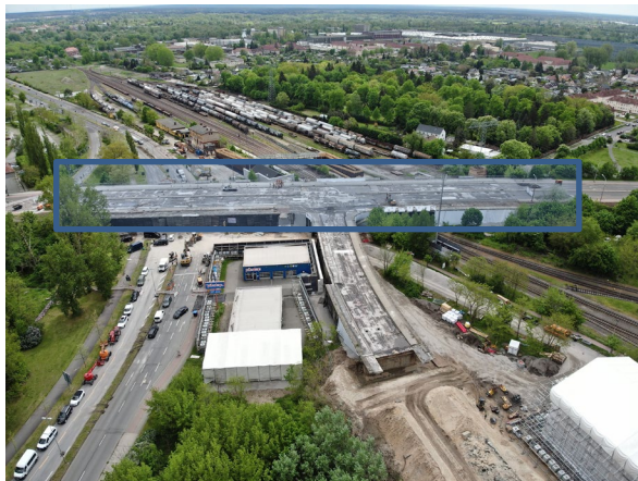
Abb. 2 Bauwerk vor dem Rückbau, Tbw. 1 hervorgehoben ifB Eigenschenk
