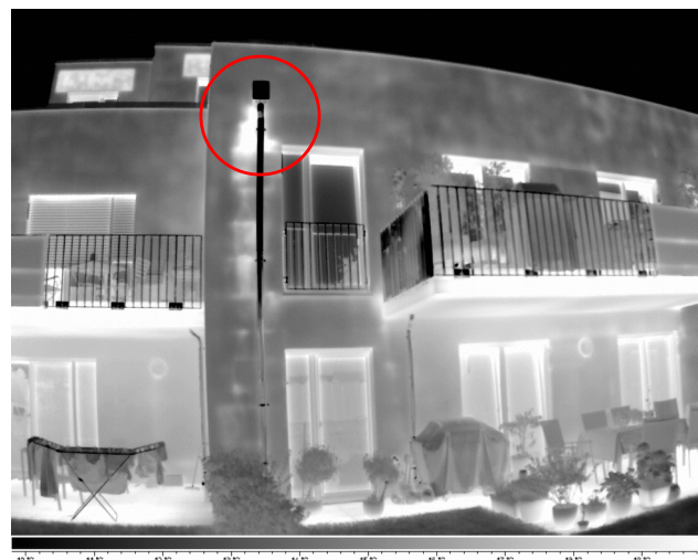
bb 1: Foto und Thermogramm eines WDVS mit undichtem Regenfallrohr (rot markiert)
